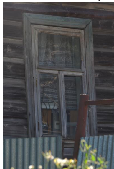
Фрагмент бокового (северо-западного) фасада, окно 2-го этажа.
