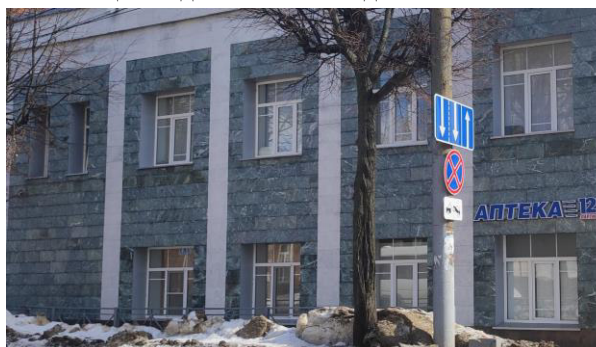
Фрагмент западного фасада. Фото 2023 г.
