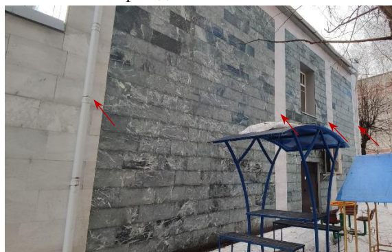
Северный фасад объекта. Фото 2023 г.
