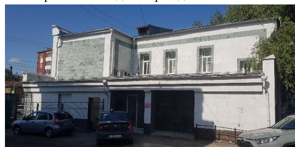
Общий вид объекта с востока. Фото 2023 г.
