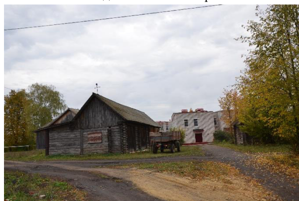
Вид на объект с запада.
