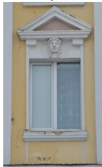
Фрагмент главного фасада, окно 3-го этажа.
