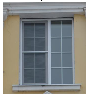
Фрагмент главного фасада, окно 4-го этажа.
