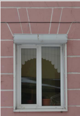
Фрагмент юго-восточного фасада, окно 1-го этажа.
