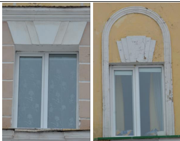
Фрагменты главного фасада, окна 2-го этажа.
