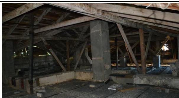
Фрагмент интерьера (чердак).
