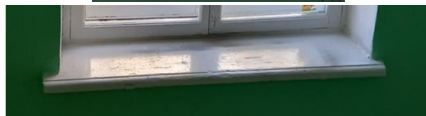
Фрагменты интерьера, окно лестничной клетки.
