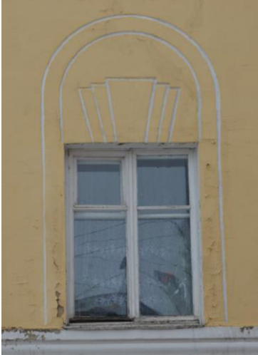
Фрагмент юго-восточного фасада, окно 2-го этажа.
