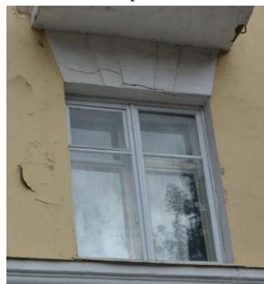
Фрагменты главного фасада, окна 2-го этажа.
