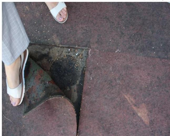
На поверхности покрытия имеются просадки. В местах просадок скапливаются загрязнения.
