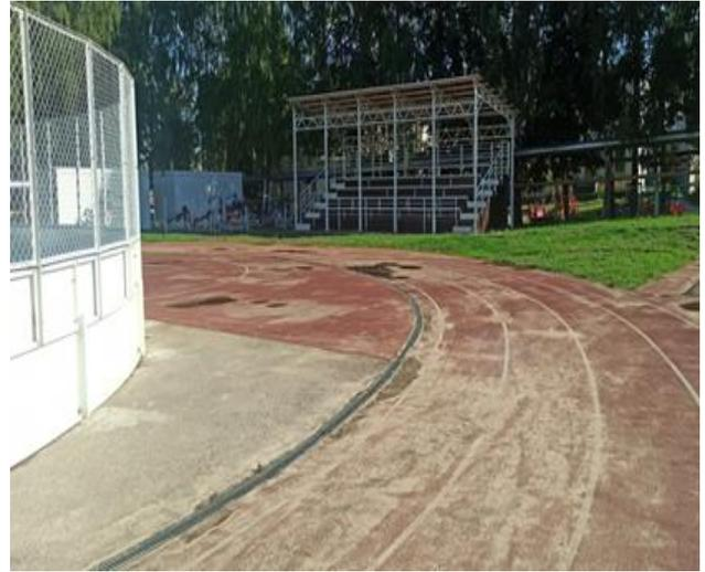
На поверхности покрытия имеются просадки. В местах просадок скапливаются загрязнения.
