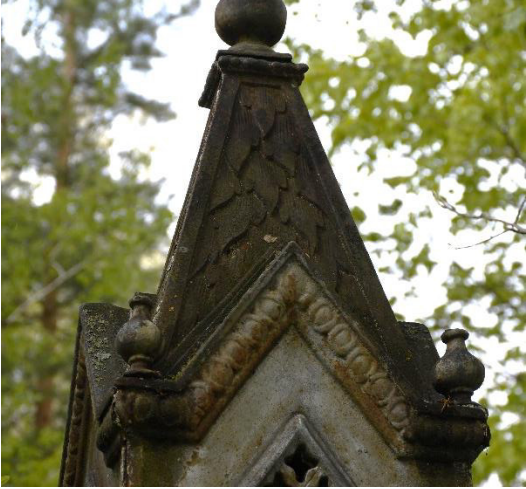
Фрагмент восточного фасада.
