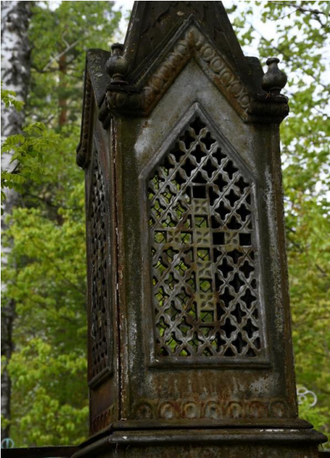
Фрагмент восточного фасада.
